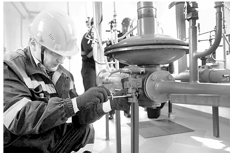
Ремонт газового оборудования в котельных Донбасса. Фото пресс-службы Министерства строительства и жилищно-коммунального хозяйства ДНР.
