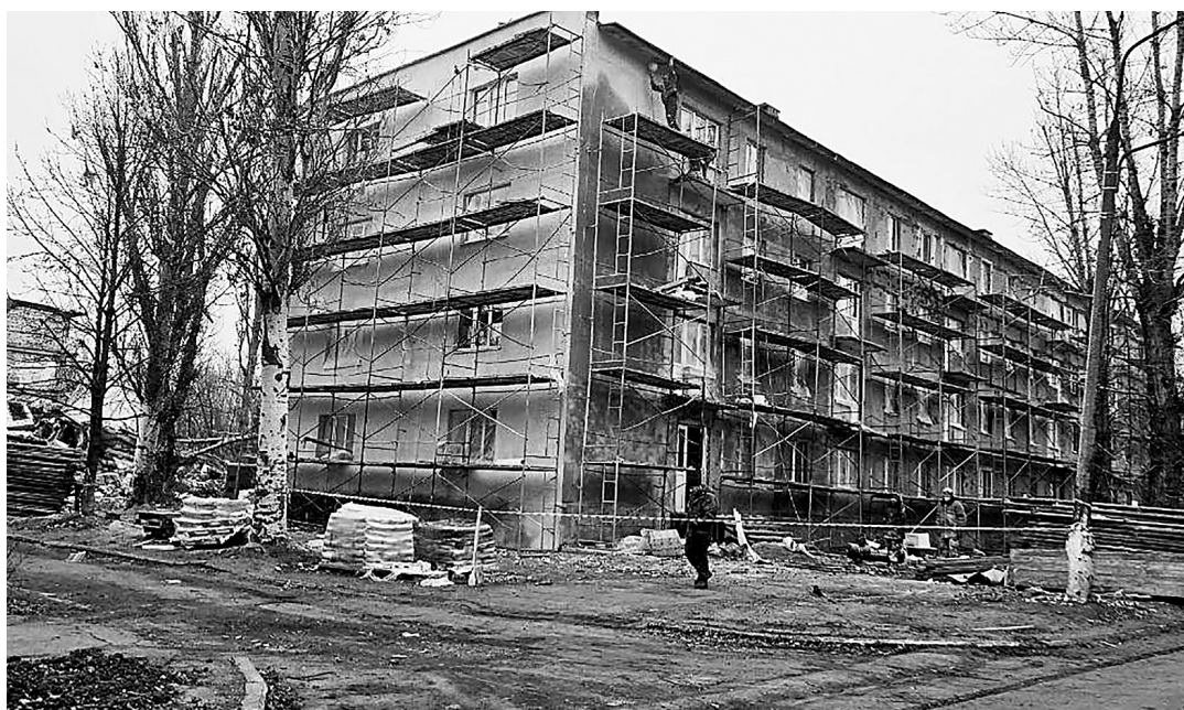
Восстановление многоквартирного дома в Авдеевке. Фото правительства Челябинской области.
