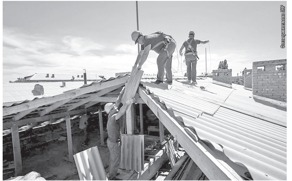
■ Московские специалисты выполняют ремонт многоквартирного дома
