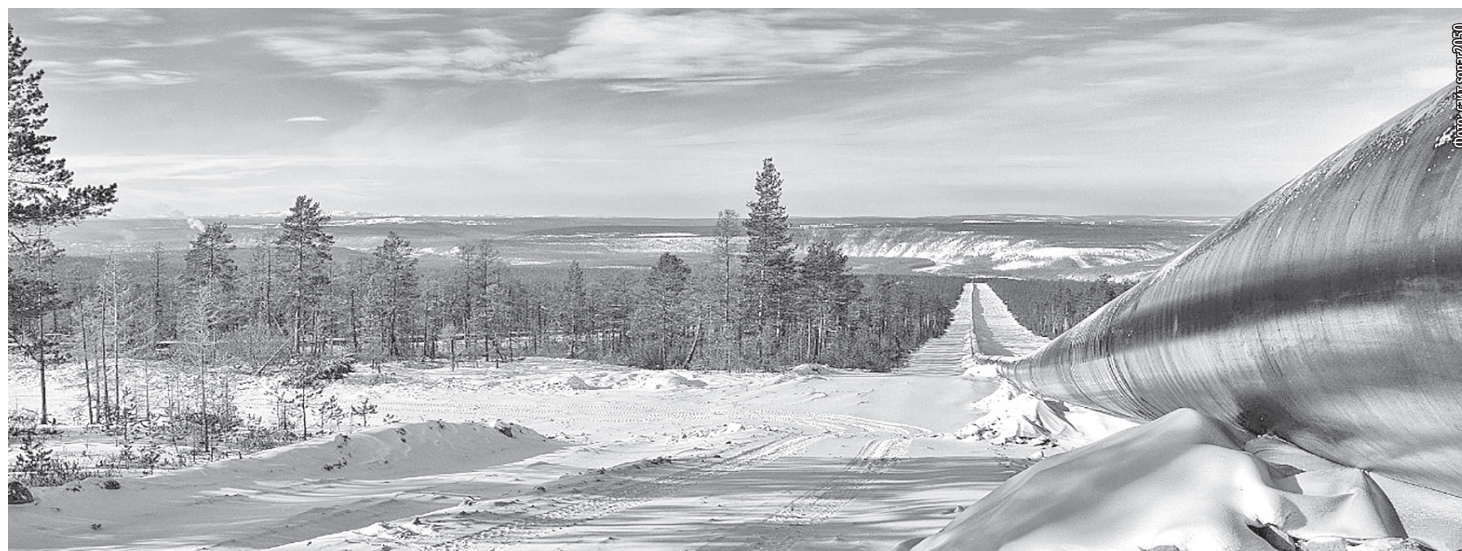
■ Протяжённые газопроводы – уязвимые объекты
