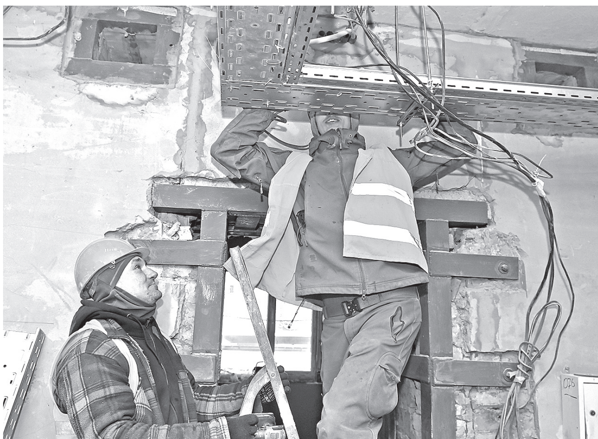
■ Строительные будни «Локомотива»
