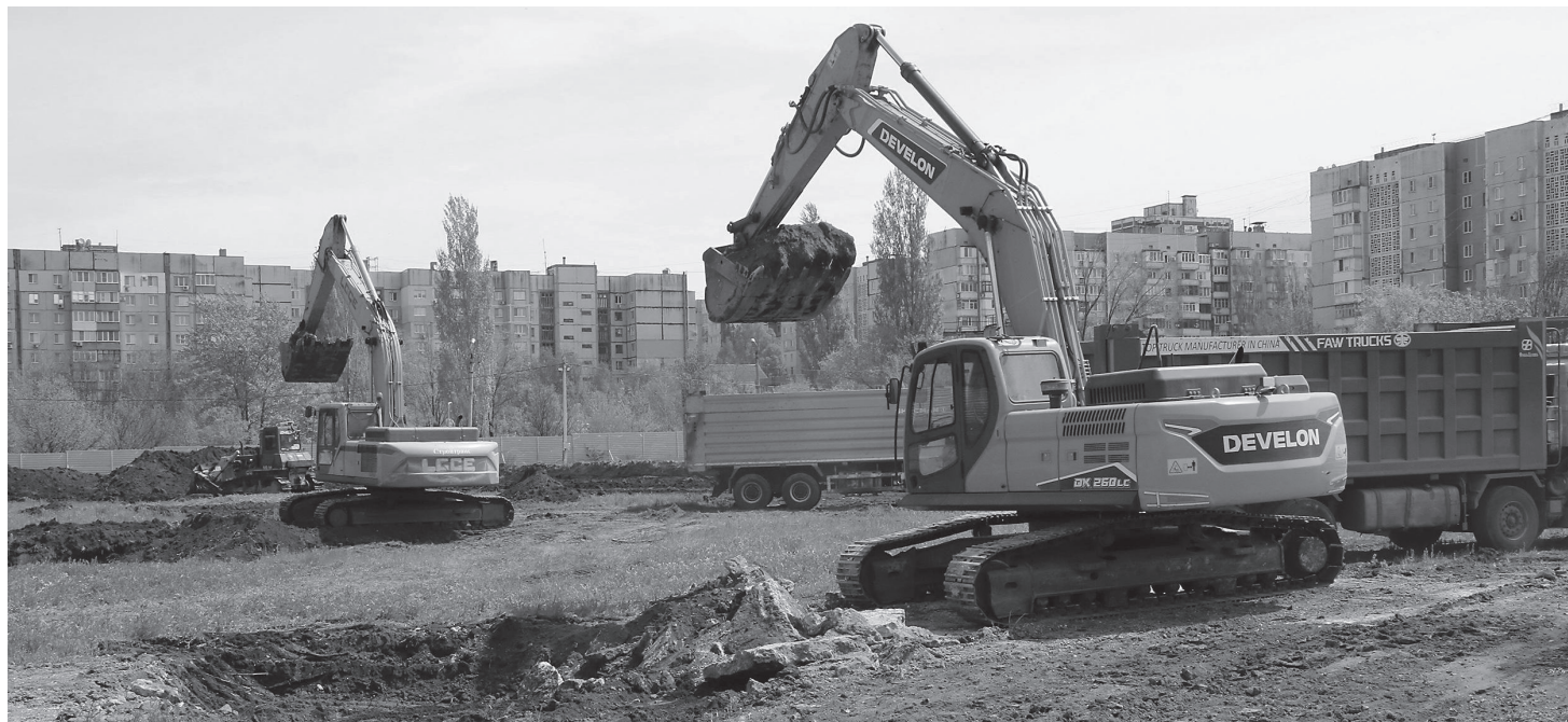
Старт строительства комплекса: в 2028 году в Будённовском районе Донецка появится квартал нового уровня
