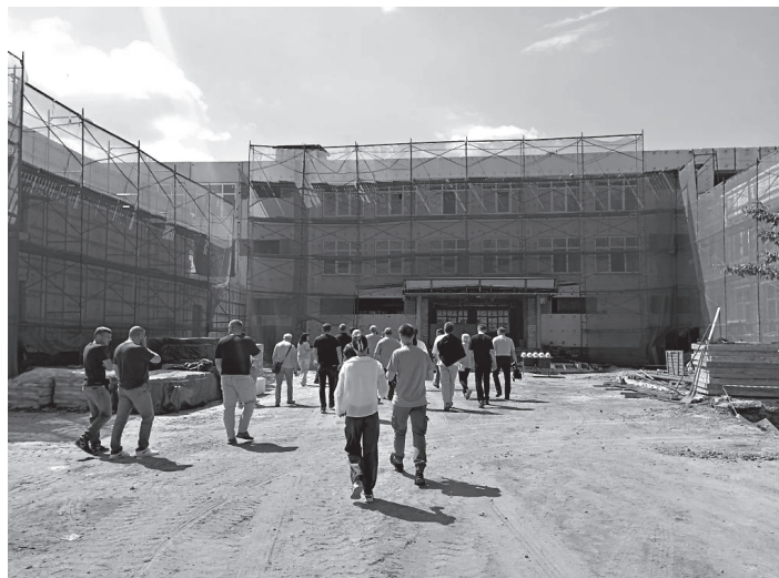
Фасад здания будет завершён уже в первых числах июля, остаются только отделочные работы
