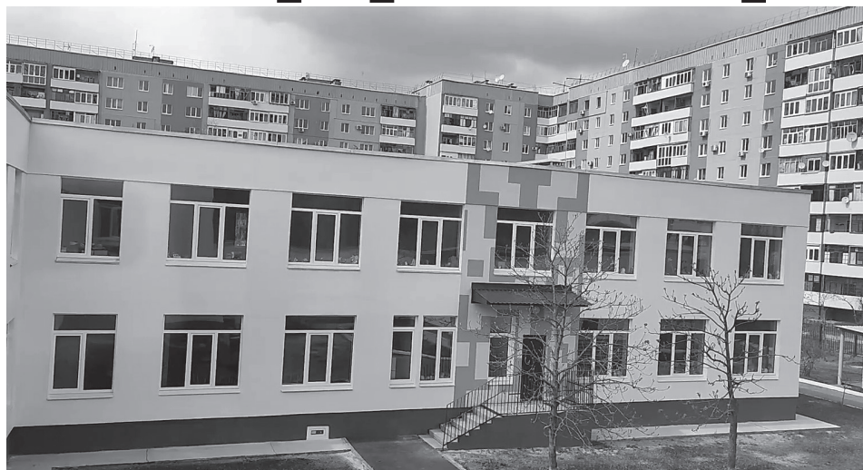
Восстановленный детский сад и девятиэтажка на восточной окраине Северодонецка лишь два из сотен отремонтированных объектов
