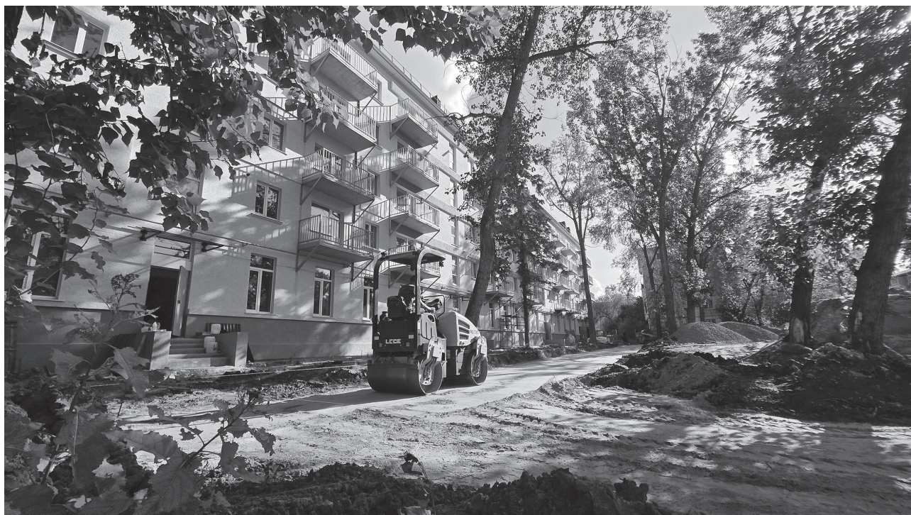
Силами специалистов региона-шефа Москвы за четыре года в регионе отремонтировали более 2000 многоквартирных домов
