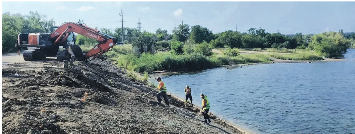
До 2027 года обновят сооружения на двух крупнейших водохранилищах республики, предотвращая потери и затопления
