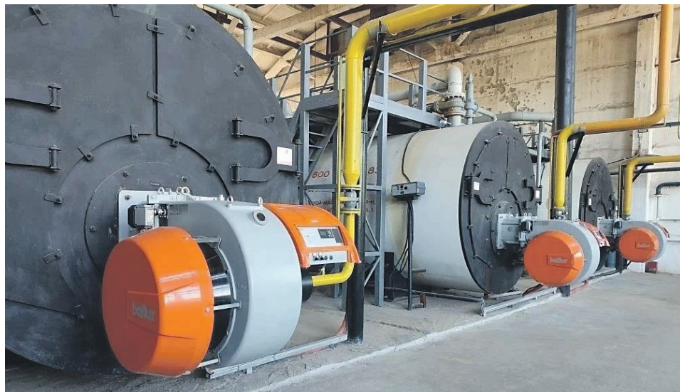
Перед сезоном холодов монтажники устанавливают новые насосы и проверяют оборудование котельных
