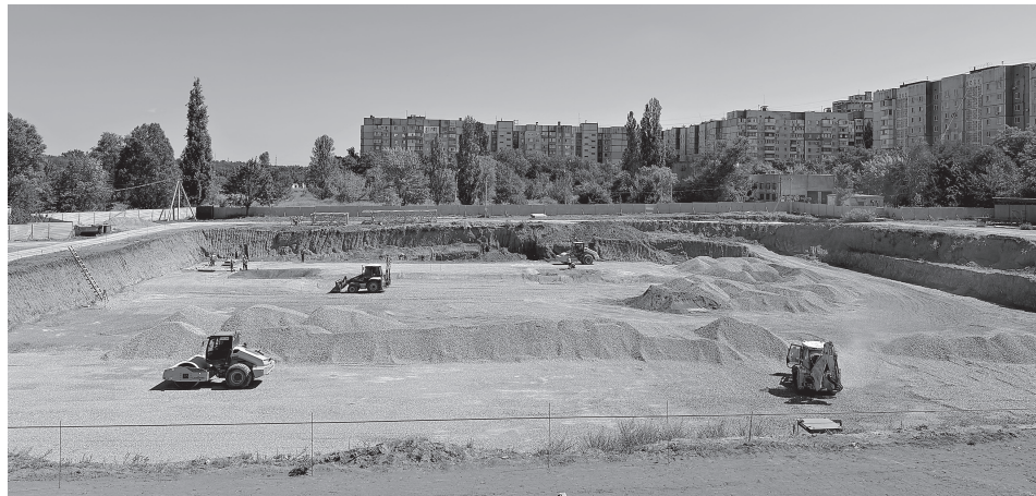
На площадке «Половецкого» уже готовят основание под первые конструкции
